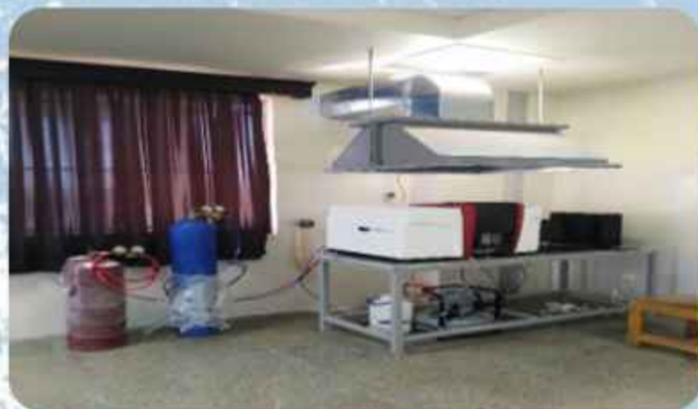
نصب هود در آزمایشگاه شیمی
